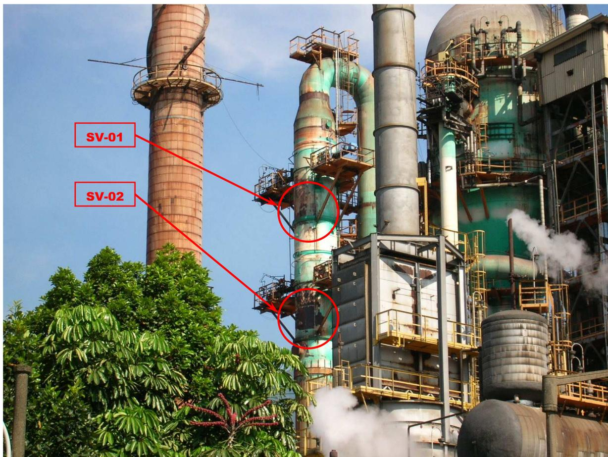
Figura 2 – Posição da ocorrência de queda do revestimento refratário
