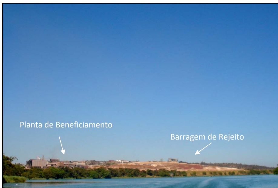
FIGURA 24 - Planta de Beneficiamento de Zn. Barragem de rejeito de Zinco localizada à margem direita do Rio São Francisco.
