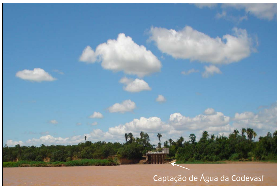
FIGURA 25 - Área da captação de água da CODEVASF, destinada ao projeto de fruticultura, localizado no município de Pirapora.
