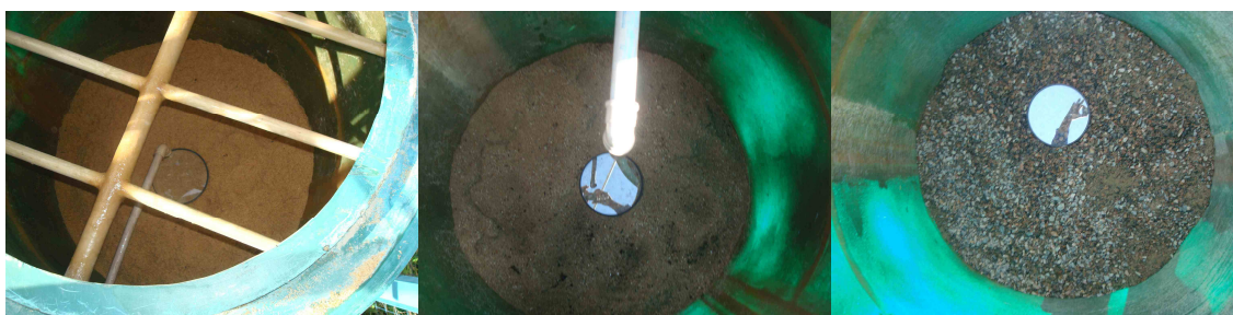
Figura 19 - Vista interna dos FILAs- distribuição do afluente.
