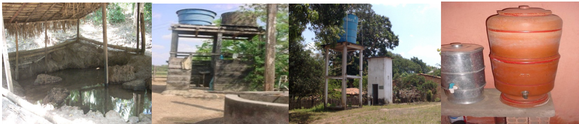
Figura10 - Água de consumo humano: fonte, poço raso, poço artesiano e filtro de cerâmica
