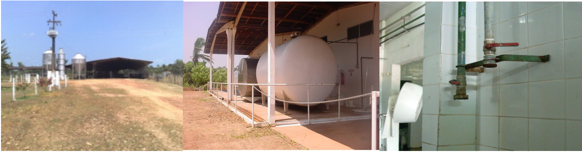
Figura 13 - Água de uso em laticínio: torneira
