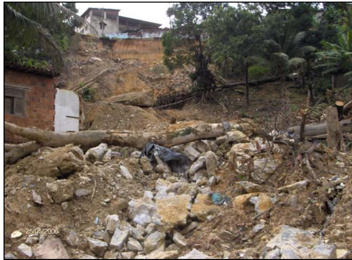
Figura II.7: Deslizamento na Zona Sul do Recife (2006)
