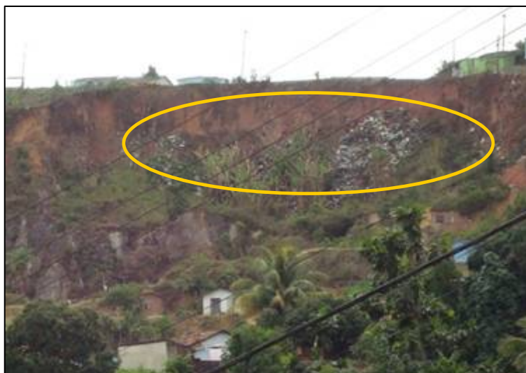
Figura II.15: Lançamento de Lixo no Talude (Encostas da RM-Recife)
