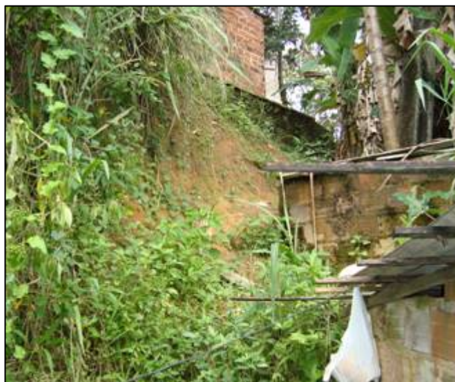
Figura VI.18: Talude de Solo Residual do Complexo Granito-Gnaiss (Alberto Maia / Camaragibe)
