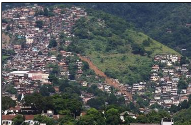
Figura II.20: Deslizamentos no Morro dos Prazeres em Santa Tereza - Rio de Janeiro (em 06 de abril de 2010 / mais de 30 mortes) / (Foto: http://oglobo.globo.com )
