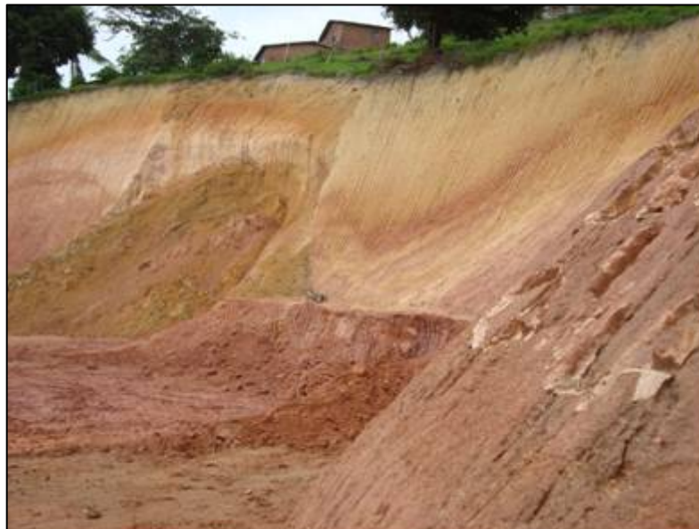
Figura V.11: Perfil de alteração de milonito com mais de 12 m de espessura em Sucupira / Jaboatão dos Guararapes
