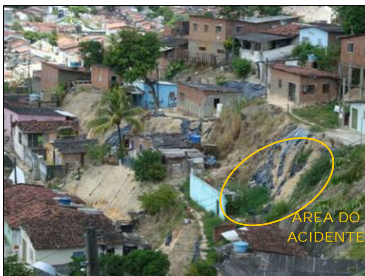
Figura VII.21: Deslizamento com Destruição do Imóvel em 13/06/09 (Zona Sul do Recife)
