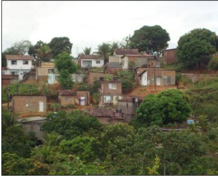
Figura VI.8: Ocupação em Solo Residual de Rocha Gnáissica-Granítica (Alberto Maia / Camaragibe)
