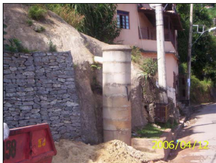
c) Obras estruturais / Saneamento
