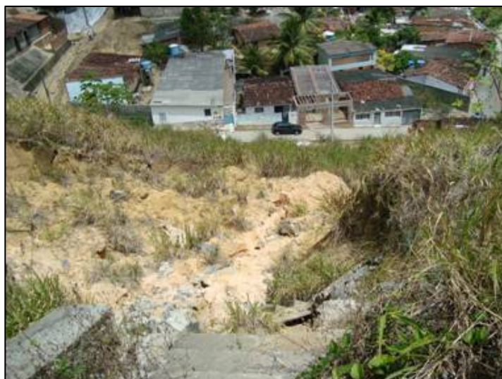
Figura VII.20: Vista de Área de Deslizamento com Morte Devido à Vazamento de Tubulação de Água, em 14/01/09 (Zona Sul do Recife)
