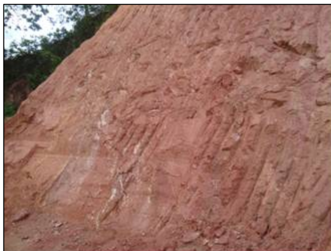
Figura VI.17: Talude de Solo Residual de Milonito (Sucupira / Jaboatão dos Guararapes)
