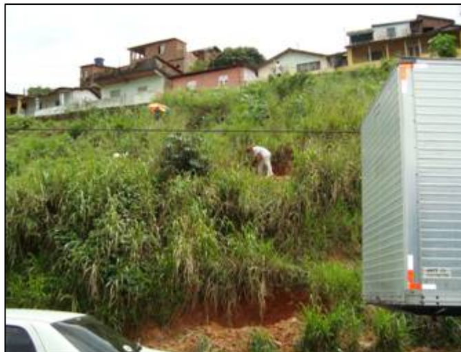
Figura VI.16: Talude de Solo Residual de Milonito (Cavaleiro / Jaboatão dos Guararapes)
