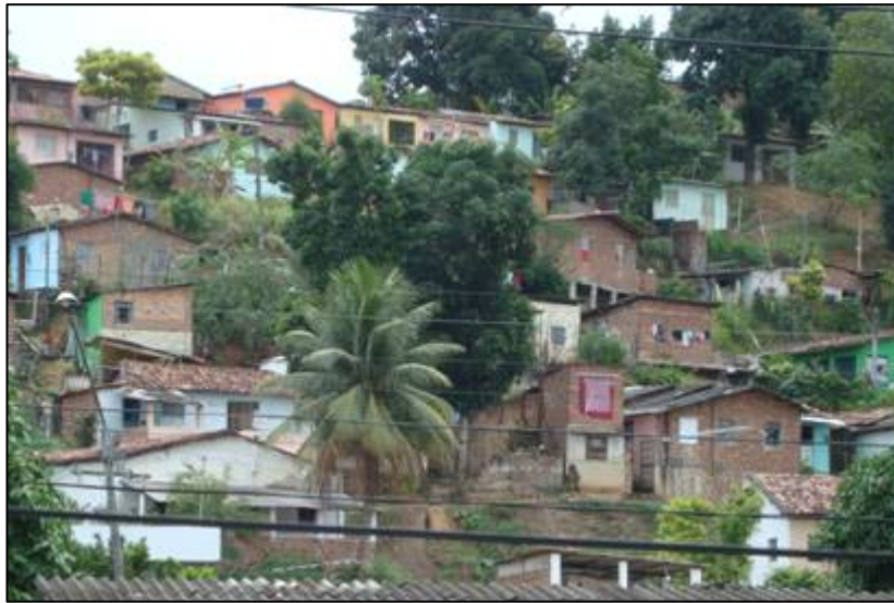
Figura VI.6: Ocupação em Solo Residual de Milonito (Sucupira / Jaboatão dos Guararapes)
