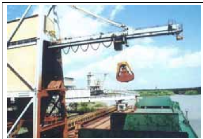
Figura 8. Embarque de carga no porto da ALUMAR, baía de São Marcos, São Luís – MA.
