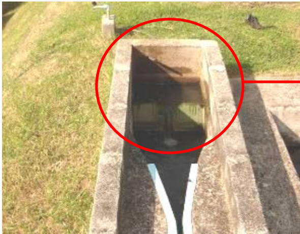
Figura 4.13 – Ponto de aplicação do lixiviado na entrada das Lagoas (LF + LM)
