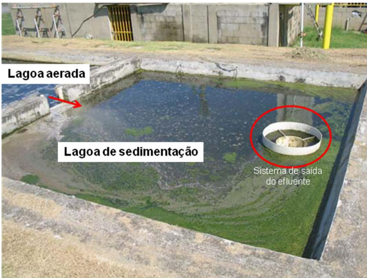
Figura 4.9 – Lagoa de sedimentação do CESA/UFRJ
