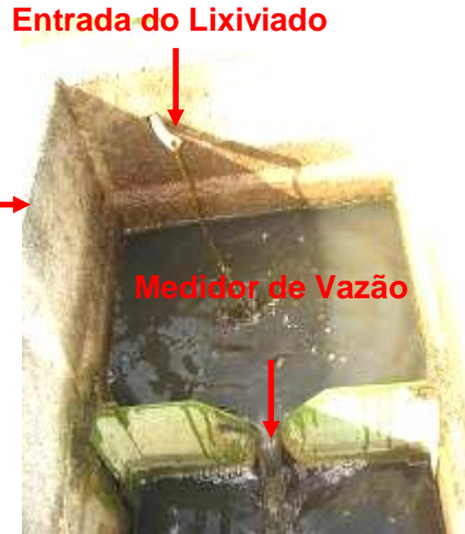
Figura 4.14 – Detalhe do ponto de aplicação do lixiviado
