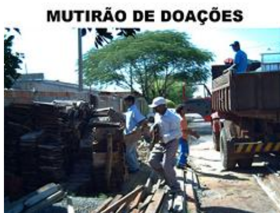
Figura 11 – Mutirão para recolher materiais doados para a construção das moradias.
