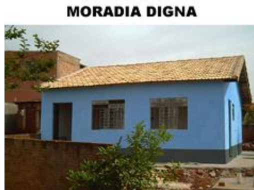
Figura 14 – Casa construída com os resíduos de construção e demolição.
