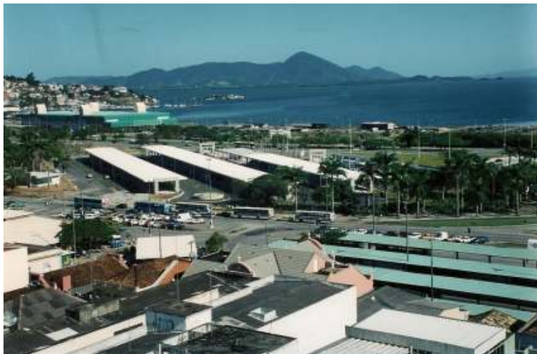
Figura 10 - Terminal do centro em construção no aterro da baía sul. Ao fundo, o centro de convenções e eventos. 64
