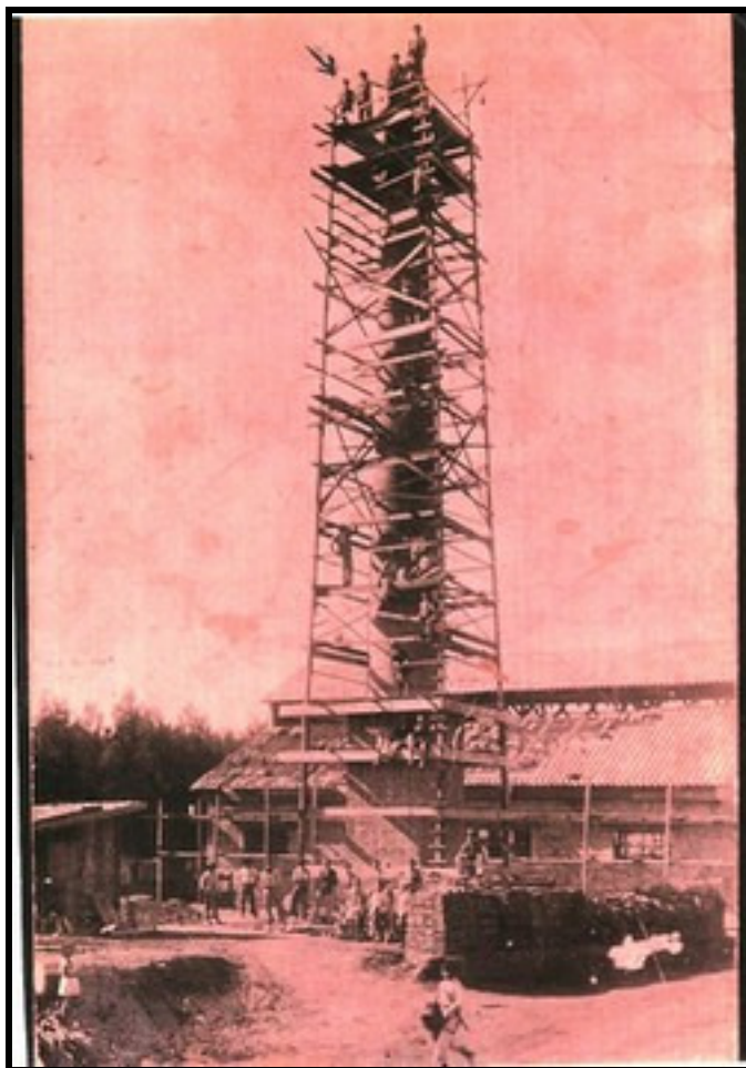
Figura 03: Construção da Chaminé da usina de eletricidade da Carbonífera Próspera S.A. [s/d]
