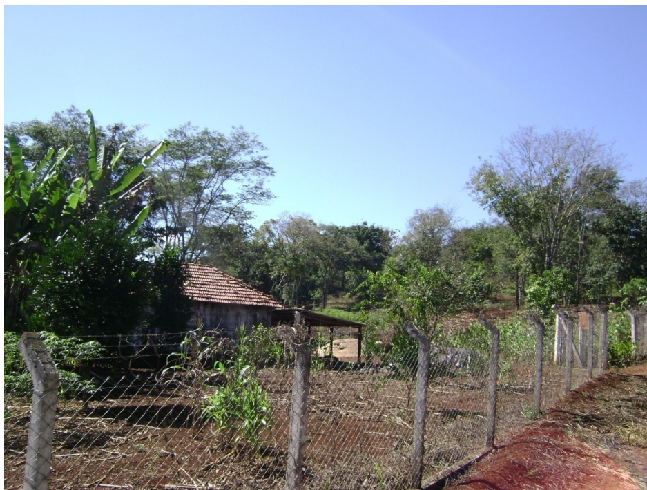
Figura 24 – Residência localizada no Condomínio Miranda VII – Fazenda Barra (localidade 96).
