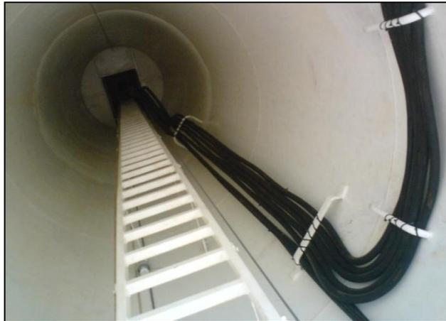
FIGURA 19: Interior da unidade geradora e os cabos que ligam o painel à nacele.
