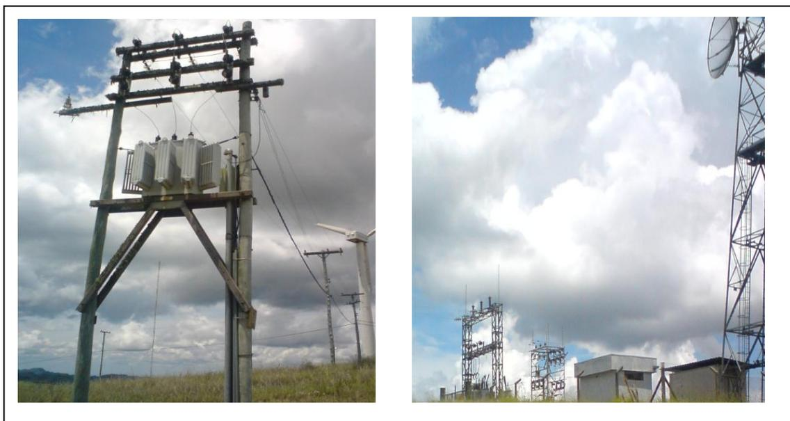
FIGURA 22-Transformador 380 V e interligação à rede de transmissão
