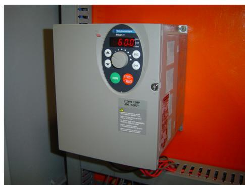
Figura 4.5: Imagem do inversor de frequência modelo Altivar 31 de fabricação da *Telemecanique*<sup>TM</sup>.
