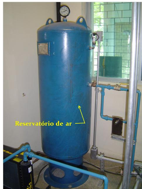
Figura 4.3: Reservatório do sistema de compressão de ar do LAMOTRIZ/UFC.
