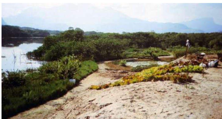
Figura 18: execução de plantio. Parque da Gleba E. Autoria: Fernando Chacel. Barra da Tijuca – RJ Fonte: CHACEL, Fernando. Paisagismo e Ecogênese . 2004. p. 53.
