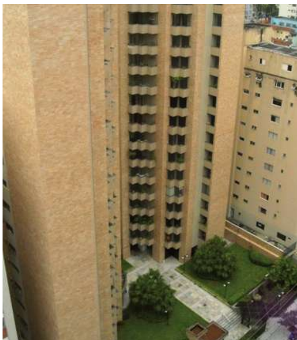
figura 49 | fachada dos edifícios Edifícios Cambury e Juquey, Perdizes, São Paulo
