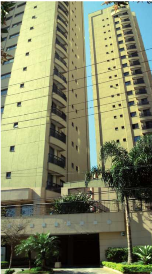
figura 71 | fachada dos edifícios
