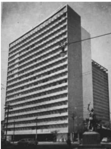
Figura 12: Edifício Nações Unidas, São Paulo, 1959 (entrega da obra)
