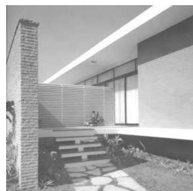
Figura 7: Residência Antonio Mauricio da Rocha, São Paulo, 1957.
