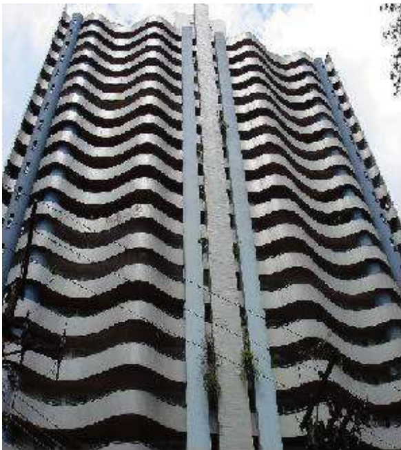
figura 41 | fachada de edifício do Portal da Cidade
