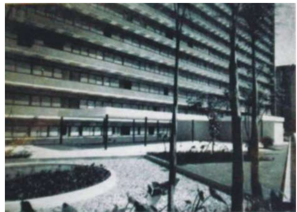
Figura 13: Edifício Nações Unidas, São Paulo, 1959 (entrega da obra)
