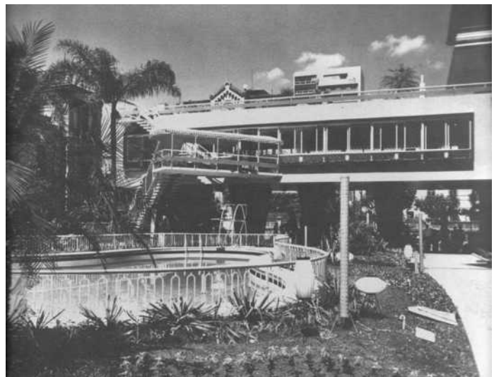
Figura 4: Edifício Bretagne. Área de lazer do edifício. Autor do Projeto: Artacho Jurado. Fonte: FRANCO, Ruy Eduardo Debs Franco. Artacho Jurado, Arquitetura Proibida .
