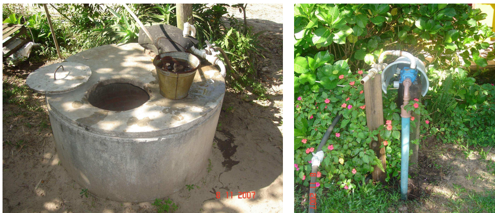
Figura 12 – Foto dos dois diferentes tipos de poços encontrados na região de estudo: cacimba (esquerda) e tubular (direita)
