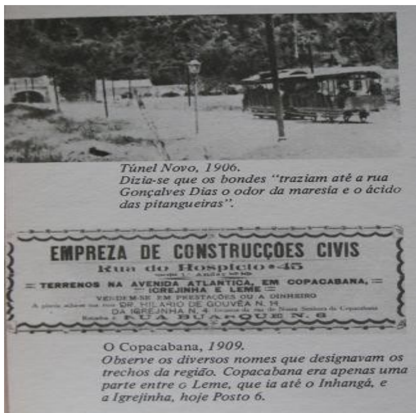
Fotografia de bonde elétrico passando pelo Túnel Novo, 1906. Abaixo, anúncio de venda de terrenos em Copacabana, anunciados pela Empresa de Construções Civis, em 1909, no jornal O Copacabana 204 .
