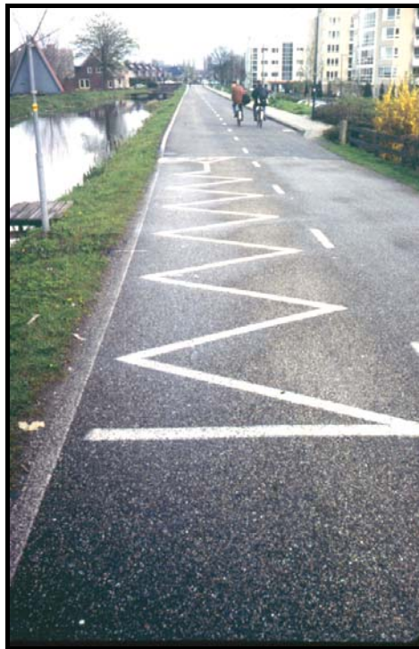
Figura 6.9: Sinalização horizontal de advertência em área de aproximação de interseção.
