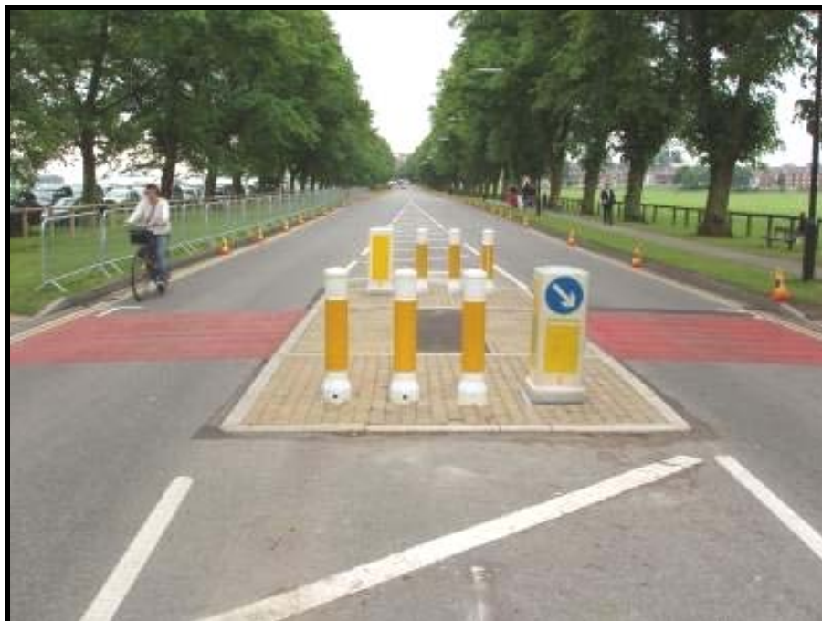
Figura 6.35: Ilha de refúgio em cruzamento.
