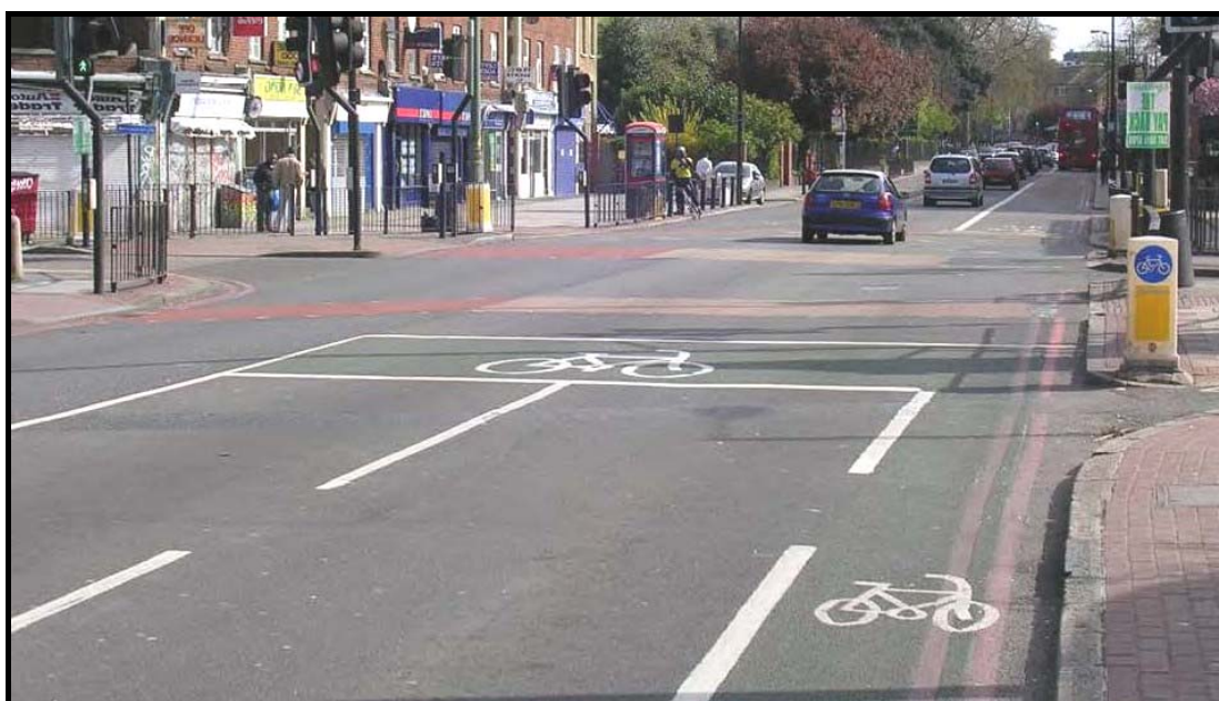
Figura 6.13: Bloco de parada avançada para bicicletas.
