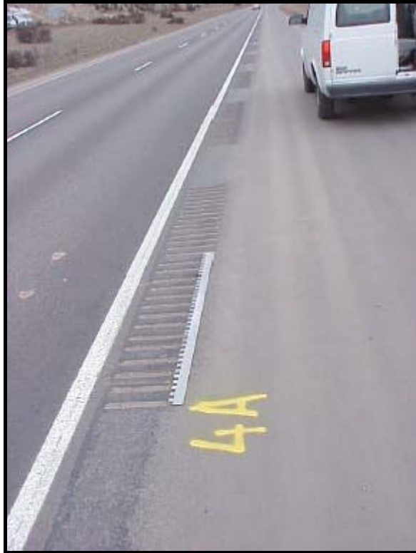
Figura 7.4: Faixa sonorizadora longitudinal.
