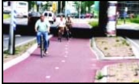
Figura 5.20: Acesso da ciclovia à vias transversais.
