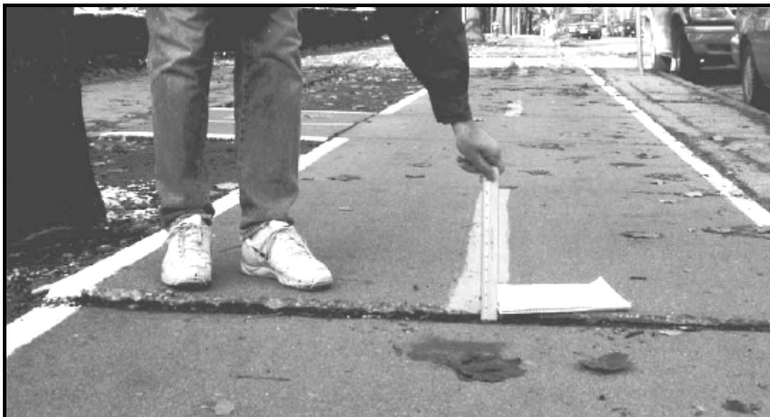
Figura 9.15: Verificação de excesso de desnível.
