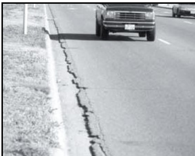
Figura 9.6: Recapeamento inadequado.
