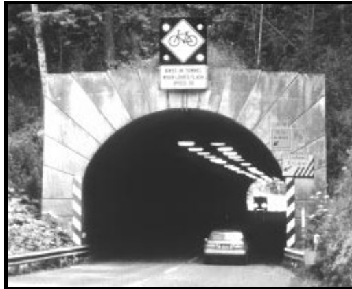
Figura 7.20: Túnel com sinalização de presença de ciclistas.
