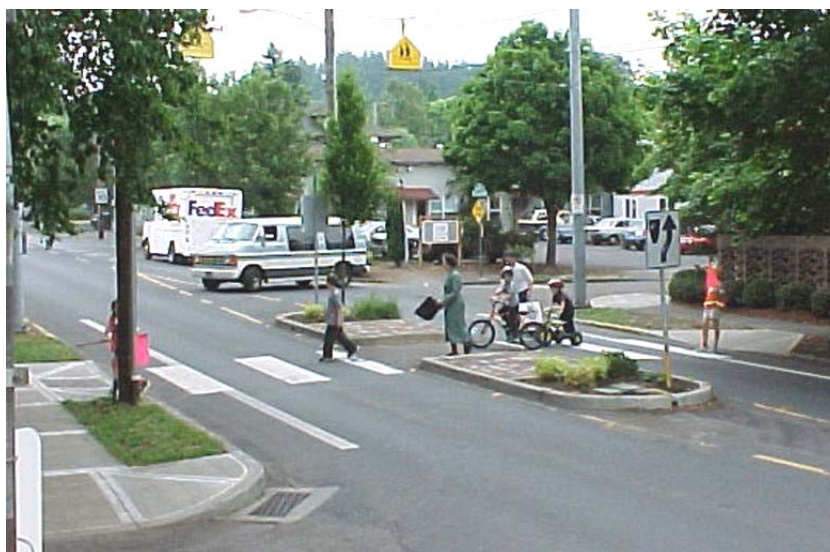
Figura 6.36: Faixa na pista de tráfego compartilhado na área de ilha de refúgio.
