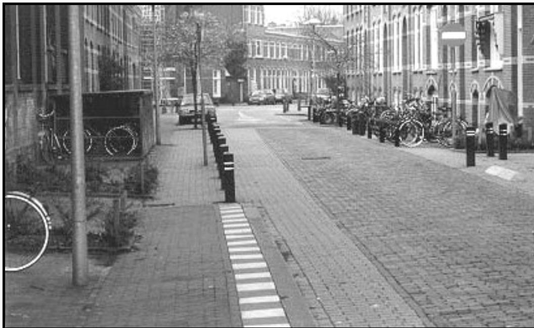
Figura 7.3: Pavimento com blocos de concreto.
