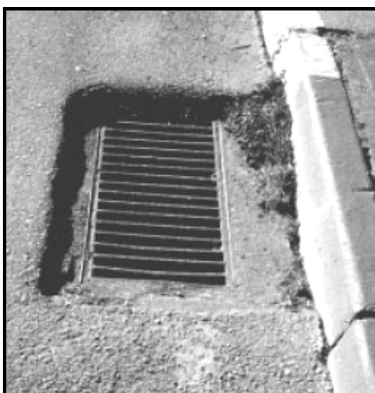
Figura 9.7: Grelha desnivelada
