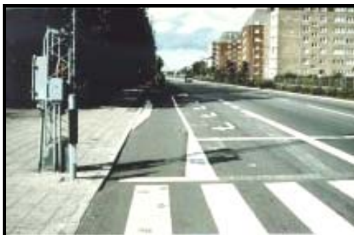
Figura 6.7: Interrupção de ciclovia (1).
