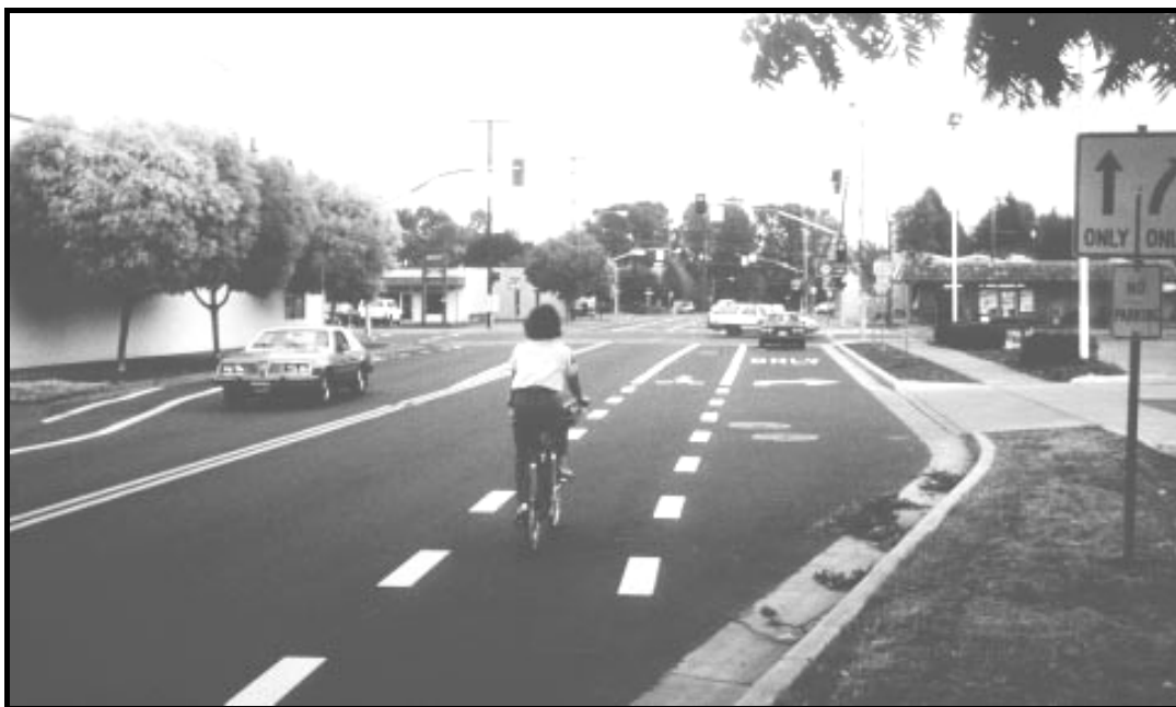
Figura 6.2: Proposta de organização da área de aproximação de faixa exclusiva para conversão à direita.
