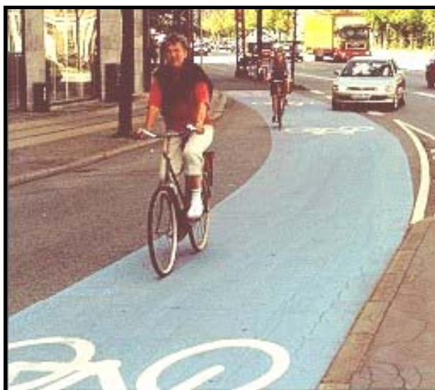
Figura 6.3: Demarcação da área de tráfego de bicicletas em local de transposição de faixas.
