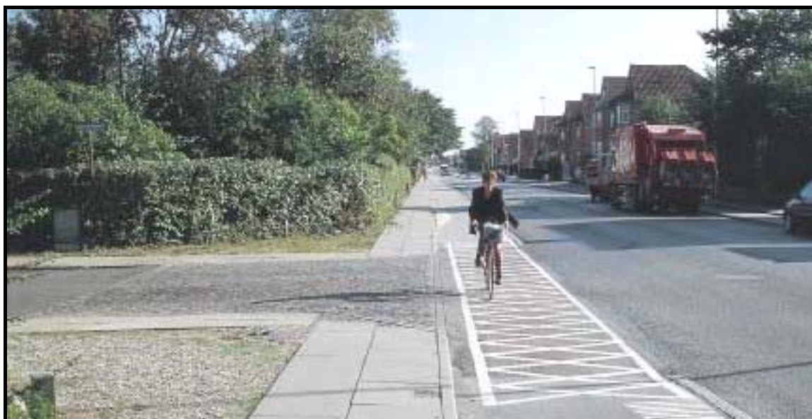
Figura 6.27: Sinalização horizontal em interseção do tipo harlequin .
