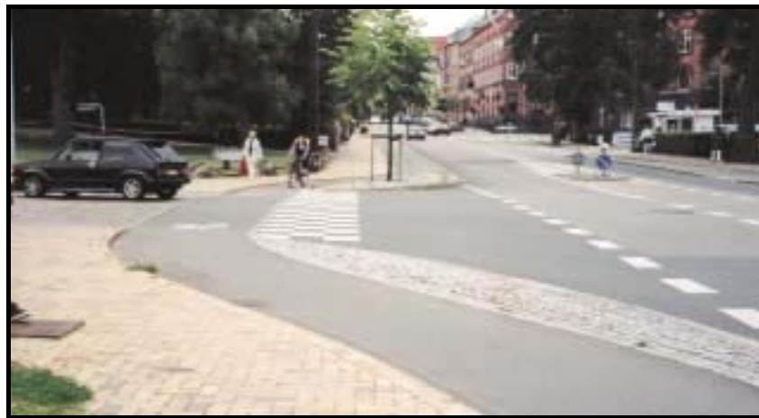
Figura 6.34: Cruzamento de via secundária com ciclovia recuada.
