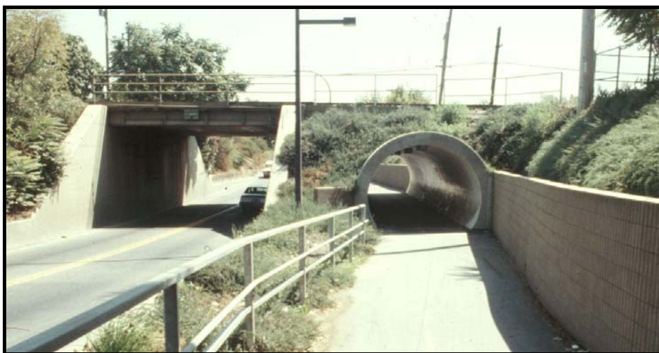
Figura 7.12: Túnel para ciclistas e pedestres.
