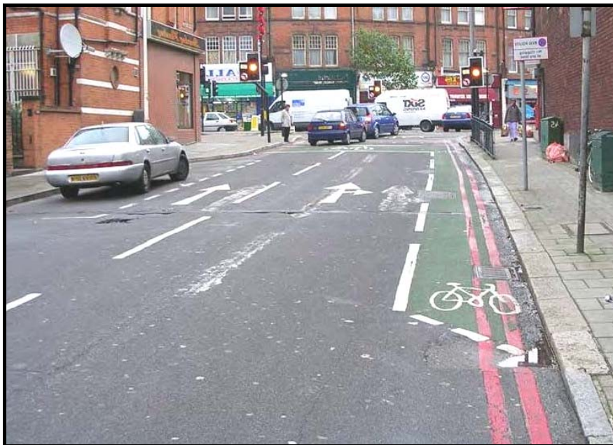
Figura 6.15: Bloco de parada avançada com ciclofaixa alimentadora.
