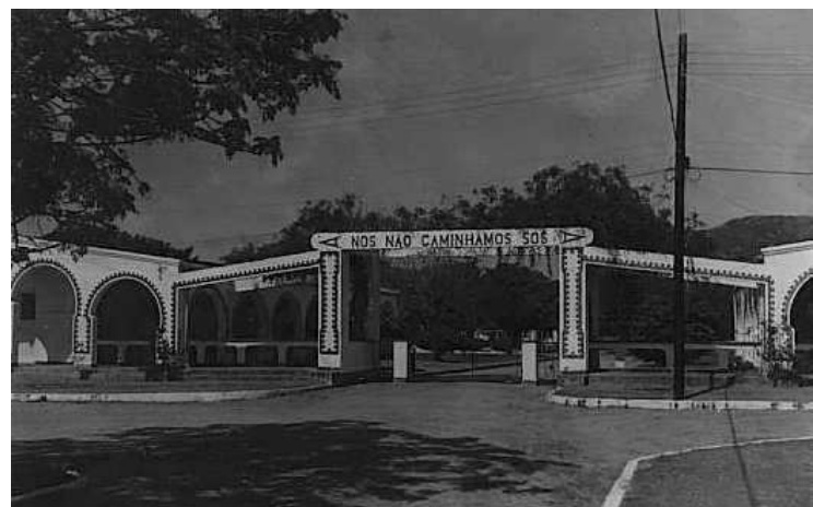
Atual pórtico de entrada. CEDOPE/HCI
