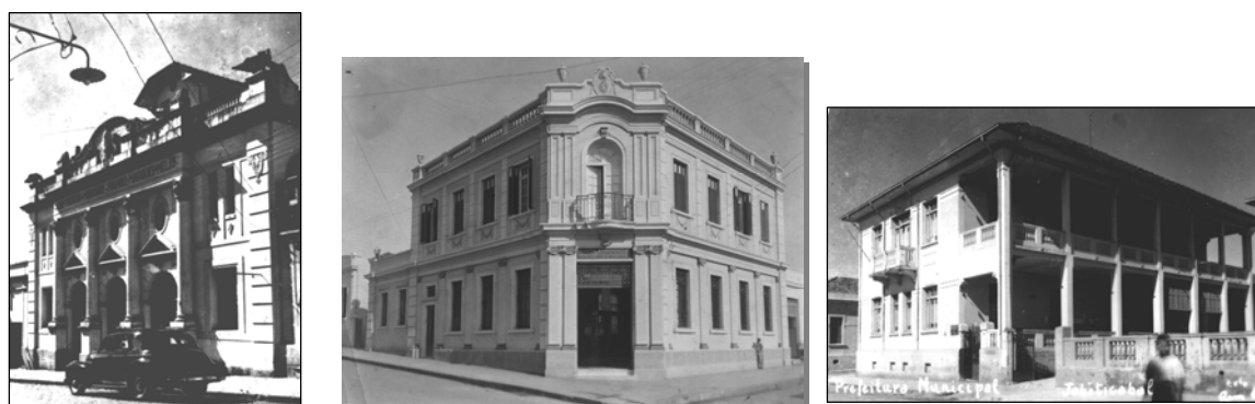
Figura 3.2 - Edifícios Históricos de Jaboticabal: Cine Teatro de 1928, Banco Comercial do Estado de 1928 e Prefeitura Municipal de 1920
