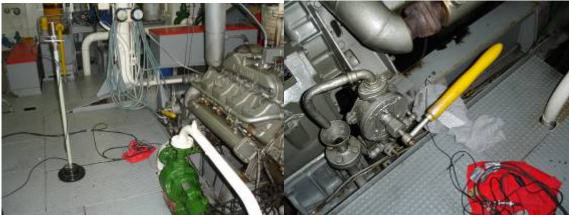
Figura 5.9 – Ponto de medição na praça de máquinas no Motor Esquerdo - ME.
