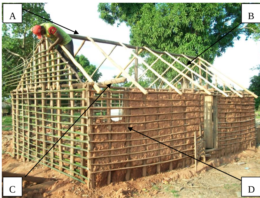
Figura 6- Compartimentação das construções, Penalva-MA; A- Cumeeira; B- Caibro; C- Grade; D- Esteio.
