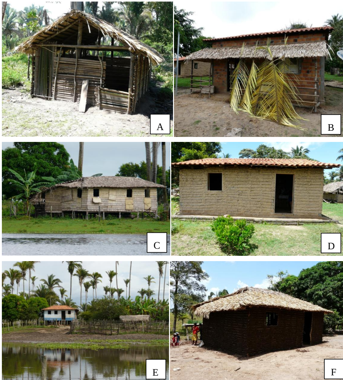
Figura 5- Categorias de construções, Penalva-MÁ; A- Madeira/palha; B- Alvenaria/telha; C- Palha/palha; D- Taipa/telha; E- Tábua/telha; F- Taipa/palha.
