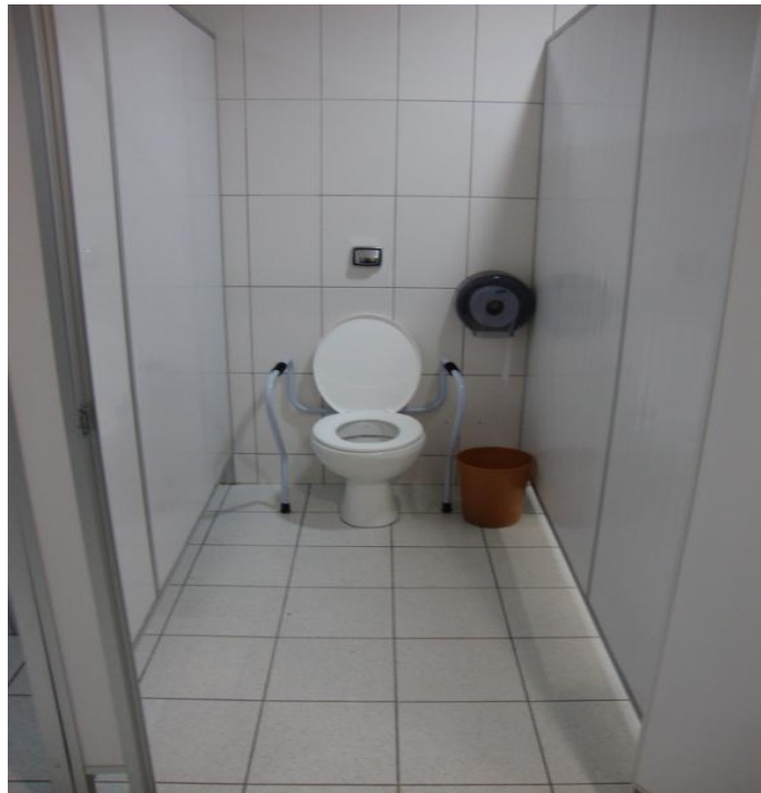
Fotografia 9: Sanitário adaptado como portas nos padrões de acesso Fonte: A autora.
