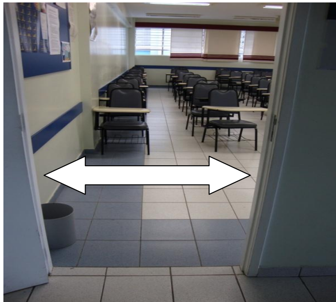
Fotografia 10: Porta de sala de aula com espaço adequado para a passagem de cadeira de rodas Fonte: A autora.
