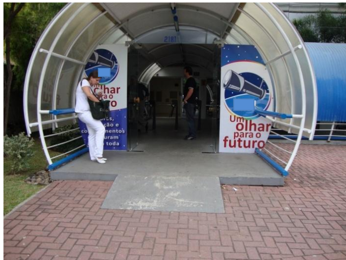
Fotografia 6: Rampa de acesso da portaria secundária da IES Fonte: A autora.
