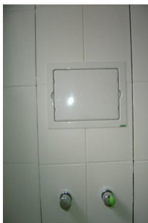
FIGURA 3.19 – A simplicidade da integração física, estética e de desempenho em shaft pivotante em ambiente sanitário.
