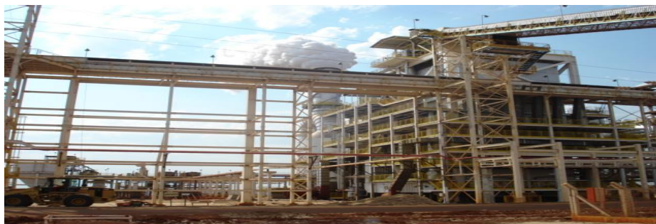
Figura 9. Caldeira em funcionamento. Fonte: Arquivo da própria Usina.
