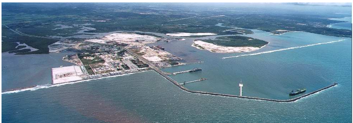
Figura 4 – Foto aérea CIPS – Complexo Industrial Portuário de Suape. (Fonte PETROBRAS)
