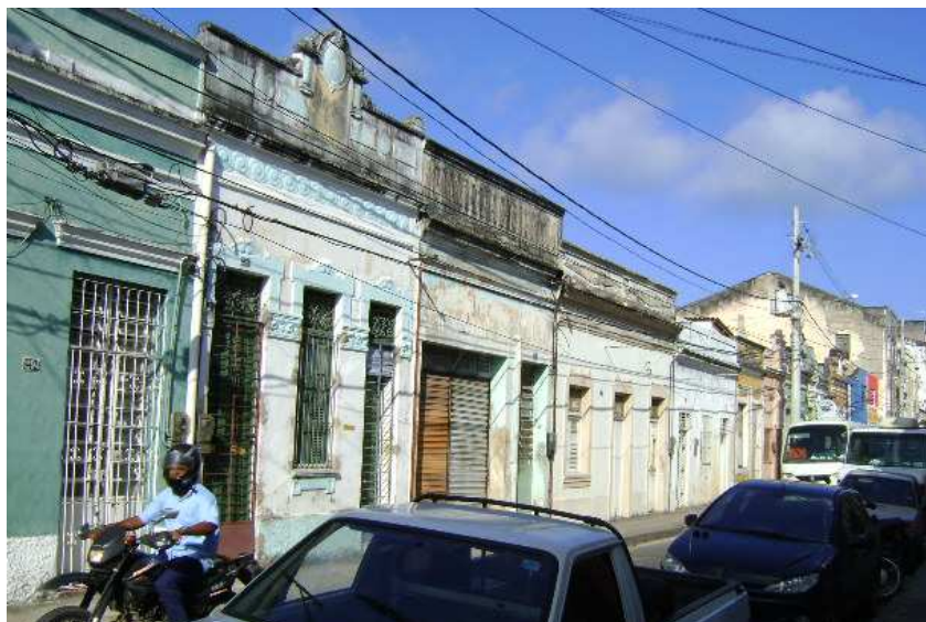
Imagem 24 – Final da Rua Velha e o estado de conservação dos casarios históricos da Boa Vista.
