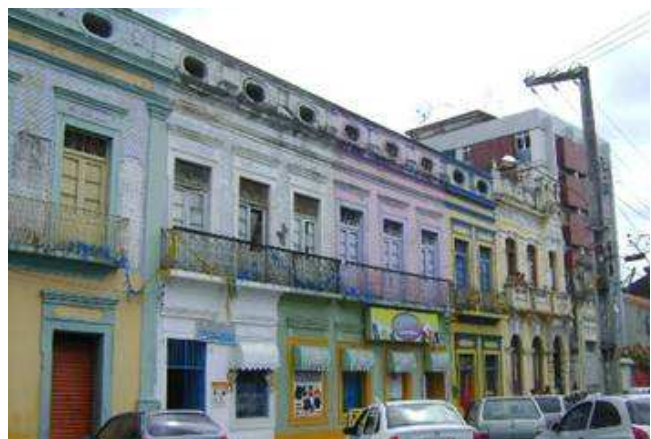
Imagem 58 – Casas em processo e envelhecimento à Rua da Soledade. Fonte: Autor.
