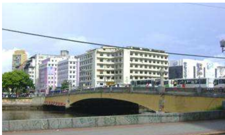
Imagem 36 – Vista lateral do edifício Pessoa de Mello. Fonte: Autor.
