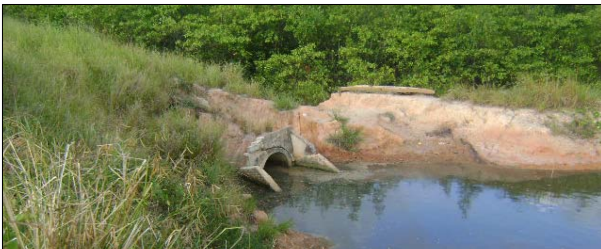
Figura 18: Fotografia do rio Tatuoca na comunidade do Engenho Mercês com intervenção de obras de drenagem pluvial oriunda dos empreendimentos de construção de estradas, alterando o regime de marés em partes do estuário. Fotógrafa: Karla Augusta Silveira (17.11.2009).
