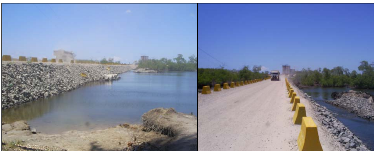
Figura 22: Fotografias do dique de enrocamento (acesso provisório à Ilha) em ângulos diferentes. Fonte: ASPAN (Ofício 01/2008).
