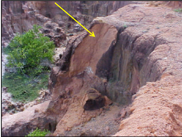
Figura III.25 – Escorregamento de material na encosta sul
