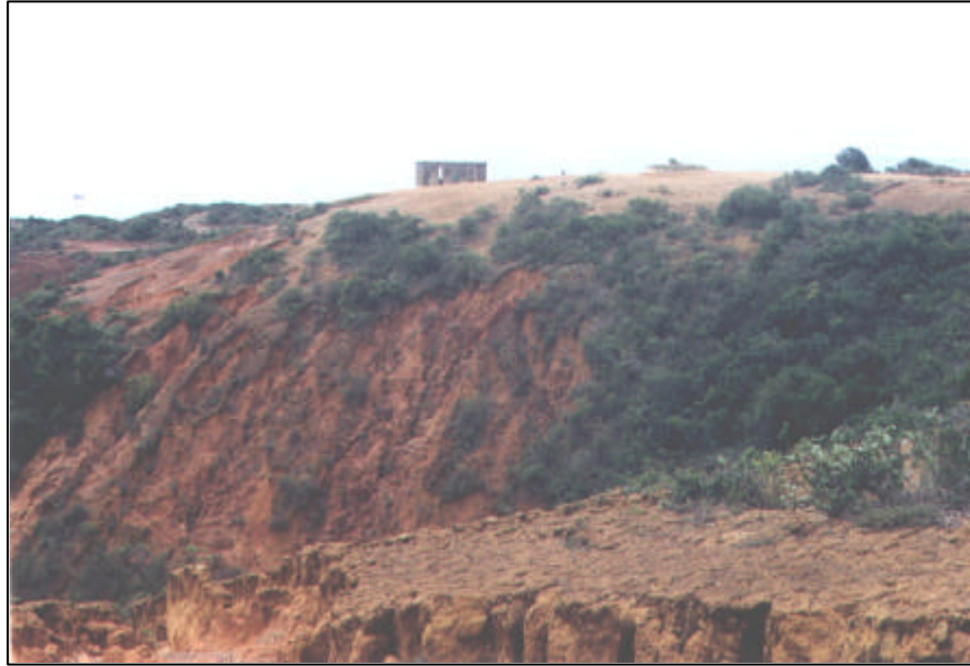
Figura I.1 - Ravina localizada próximo ao Farol - encosta central
