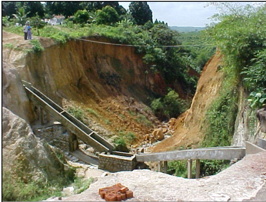
Figura II.16 - Processo erosivo por voçorocamento - Araçoiaba/ PE- AGÊNCIA CONDEPE/ FIDEM (2006)
