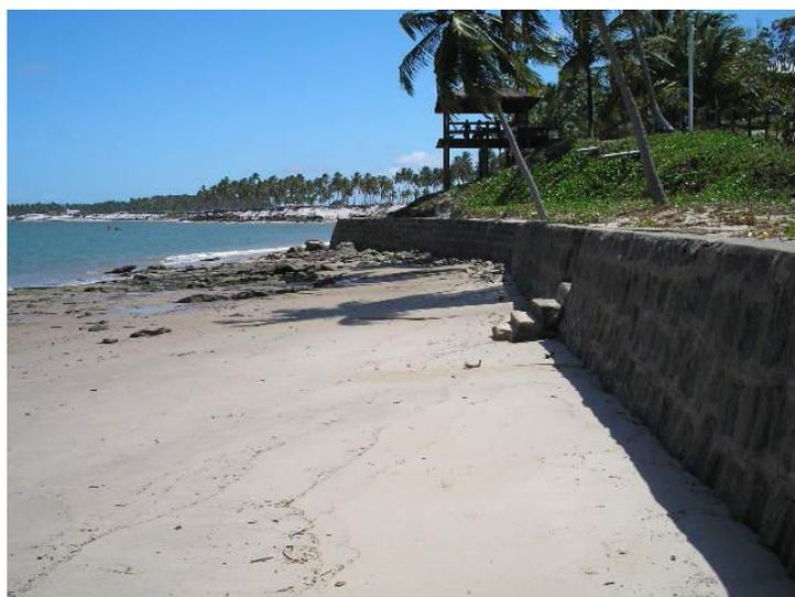
Figura 6.19 – Estação E-11, aspecto do muro de proteção na Praia de Guadalupe, setembro 2006.
