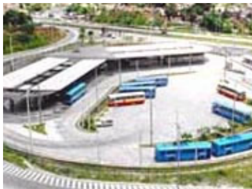
Figura 7.3 - Terminal Integrado da Macaxeira
