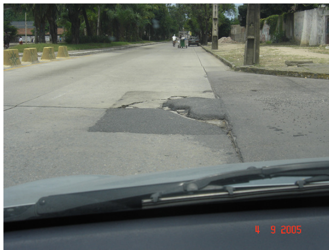
Figura 4.1 - Exemplo de estado do pavimento em algumas vias de grande circulação de ônibus.
