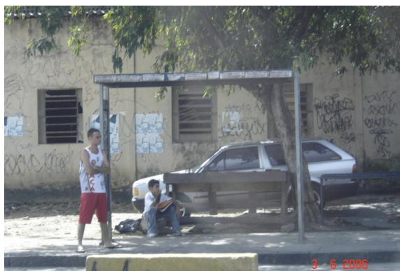
Figura 7.5 – Abrigo metálico da Avenida Norte.
