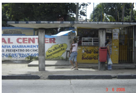
Figura 7.4 – Abrigos de concreto armado da Avenida Norte.
