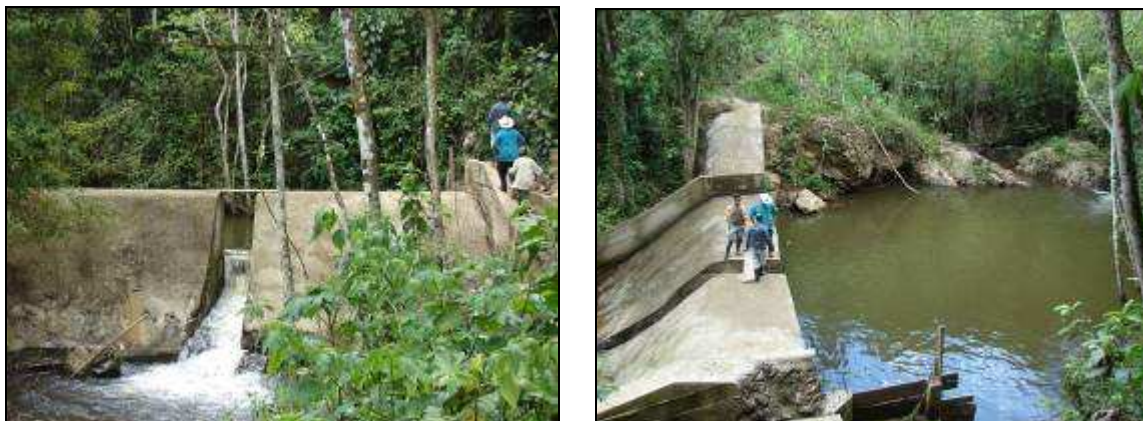
Figuras 26 e 27 – Vistas frontal e lateral da represa do projeto hidroelétrico de Nueva Esperanza. Fotos: Carlos Eduardo Menezes da Silva Jun/08
