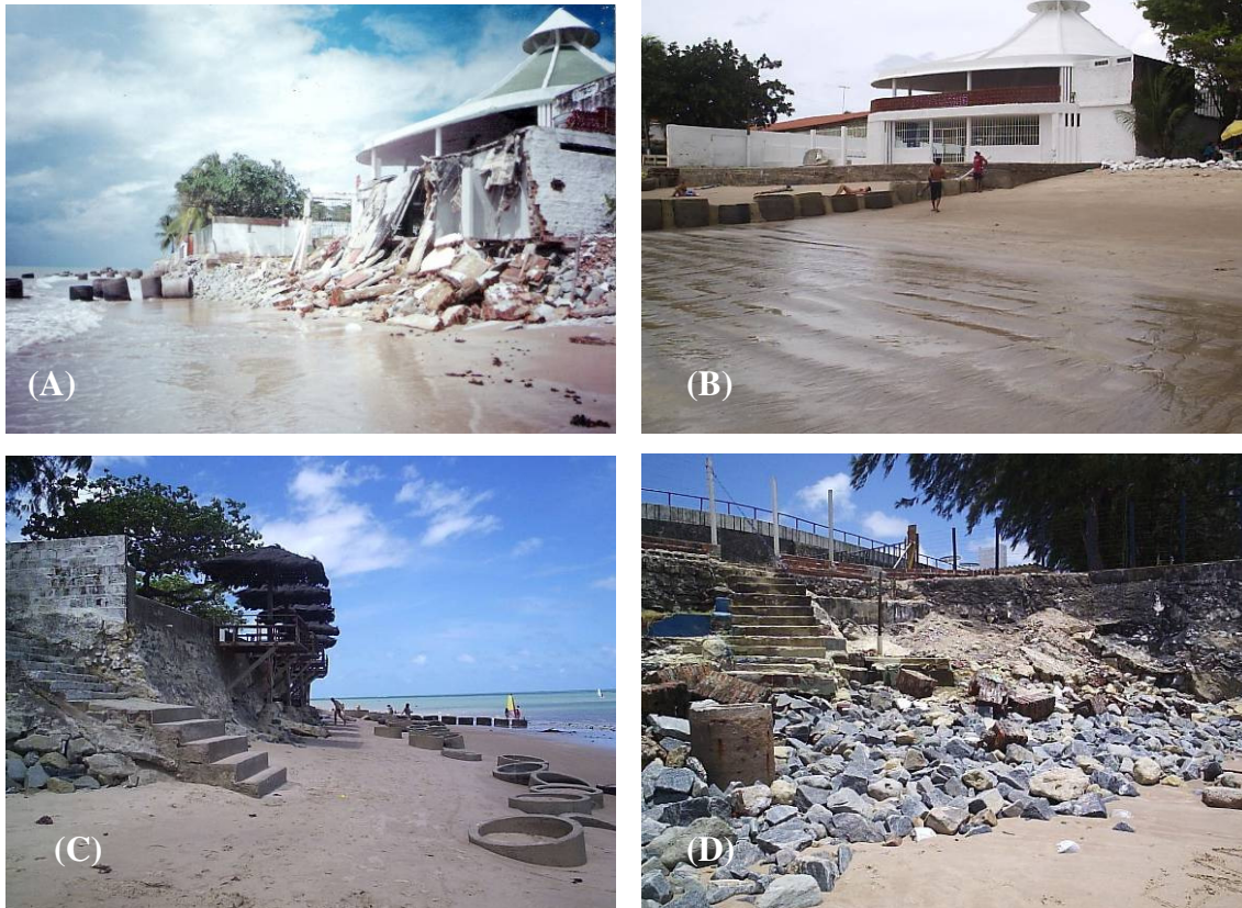
Foto 7.1 – Sub-Setor A, célula II. Detalhes da erosão na praia do Bessa. (A) Clube dos Médicos, situação em 2002, e (B) situação da praia em 2006. (C e D) Iate Clube da Paraíba, situação em 2006. Notar a colocação de pedras soltas em local crítico de erosão. Fotos da autora.
