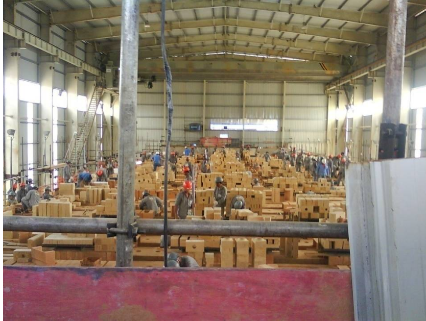
Figura 5-2: Coqueria 03 da Usiminas. Construção dos fornos (2009). Acervo do autor.
