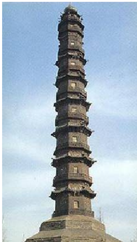
Figura 1-1: Torre de Ferro do templo de Chongjue, em Jining (fonte: CHINATHROUGHTALENS).
