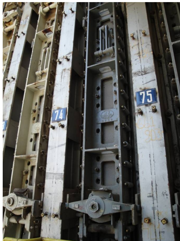
Figura 4-23: Porta de forno de coque com selagem flexível. USIMINAS (2010). Acervo do autor.
