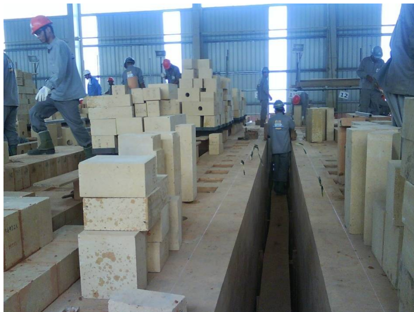
Figura 5-3: Coqueria 03 da Usiminas. Construção dos fornos (2009). Acervo do autor.
