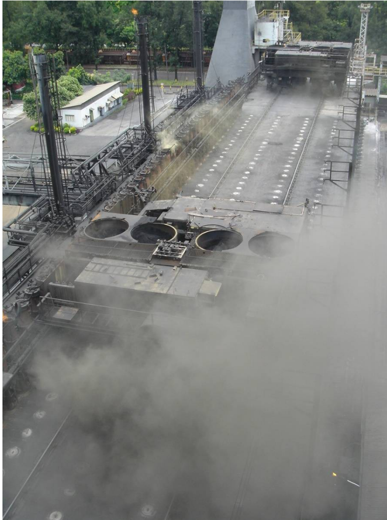
Figura 4-19: Carro de carregamento visto do coal bunker. USIMINAS (2006). Acervo do autor.
