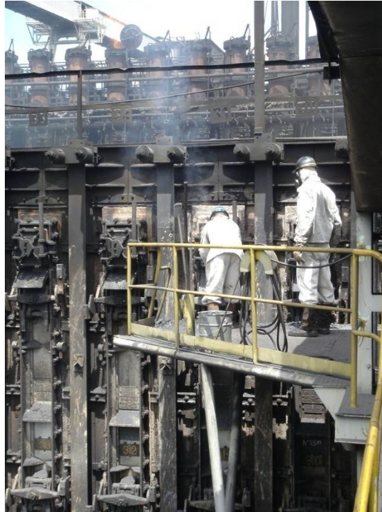
Figura 4-28: Manutenção manual de porta. USIMINAS (2006). Acervo do autor.
