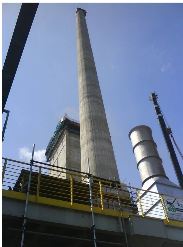
Figura 5-7: Exaustão do filtro de mangas do sistema de despoeiramento acoplado à desenfundadora USIMINAS (2009). Acervo do autor.
