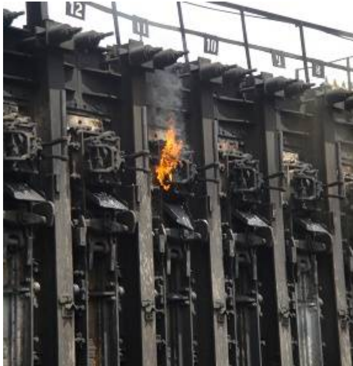
Figura 4-20: Vazamento de porta. USIMINAS (2006). Acervo do autor.
