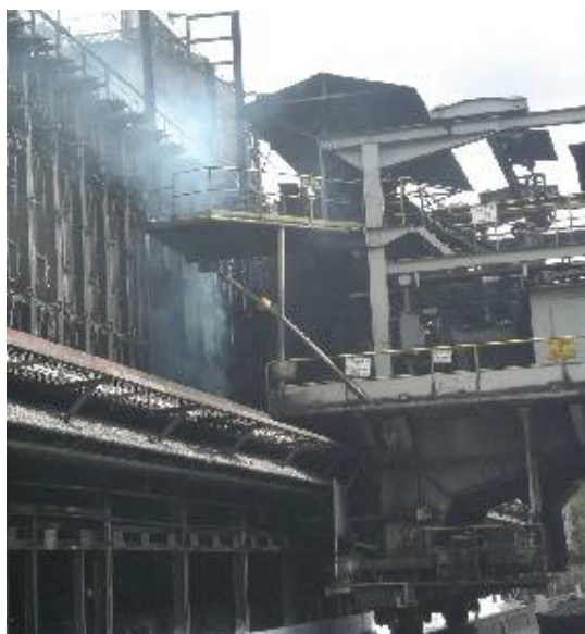
Figura 4-24: Expulsão do coque. Vazamentos. Lado da desenfornadora. USIMINAS (2006). Acervo do autor.
