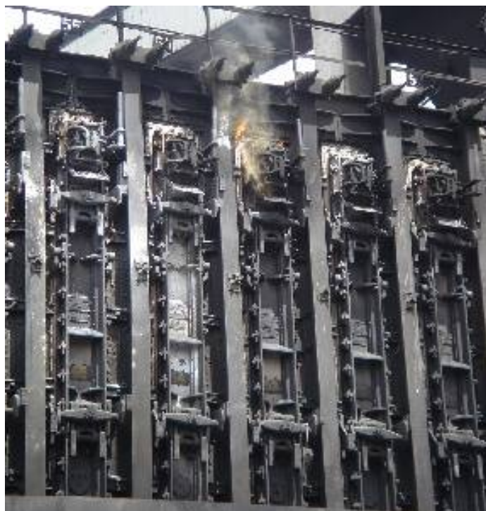
Figura 4-21: Vazamento de porta. USIMINAS (2006). Acervo do autor.
