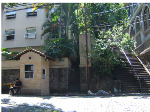
Guarita de acesso principal, escadaria e os dois únicos edifícios multifamiliares.
