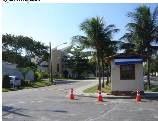
Guarita interna para vigia e Igreja ao fundo.
