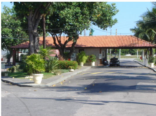
Guarita de acesso principal.
