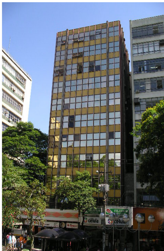
Foto 21 - Edifício Manuel Gonçalves
