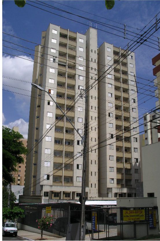
Foto 32 - Edifício Castelo Forte
