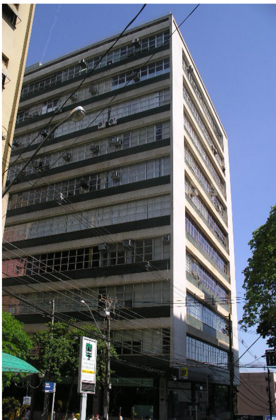
Foto 20 - Edifício Banco do Brasil
