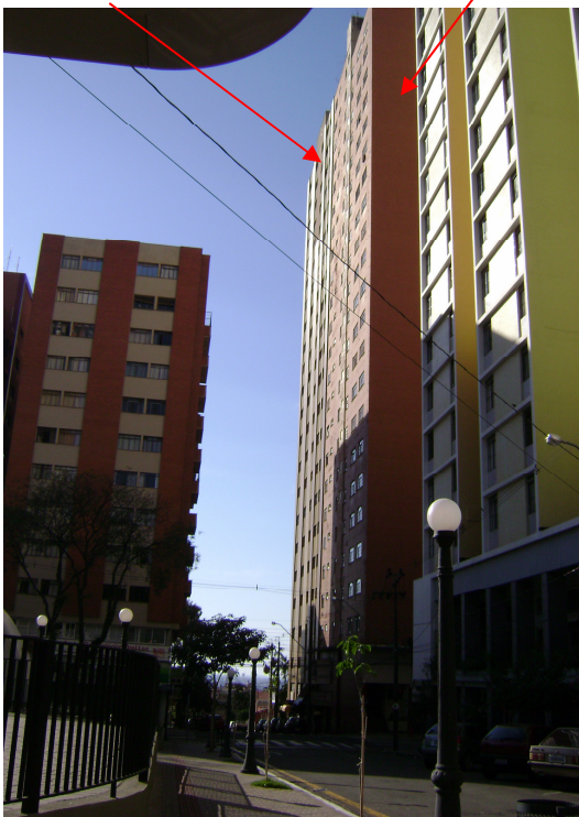
Foto 17 - Edifício Jamile Caram
