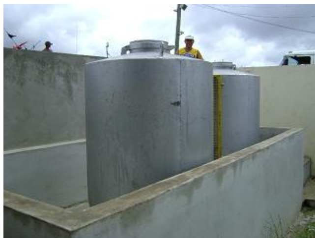
Figura 10 - Tanques reservatórios instalados
