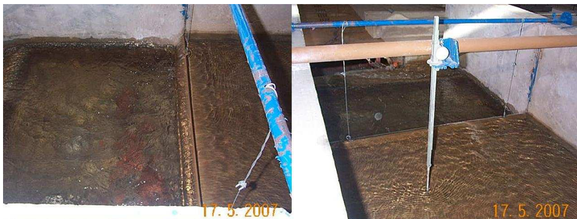
Figura 6. 9 - O nível da água a montante ultrapassou o limite da viga, passando a verter por sobre a mesma (Foto do autor).
