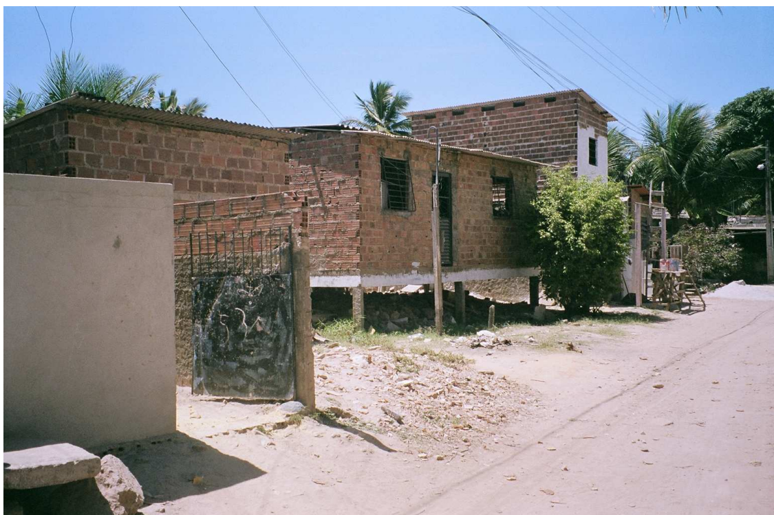
Figura 7. 8 - Construção palafita em alvenaria na área de várzea da Bacia do Rio Fragoso em Olinda/PE, 2005, protegendo a casa e deixando espaço para as águas no período de inundações (Foto do autor).
