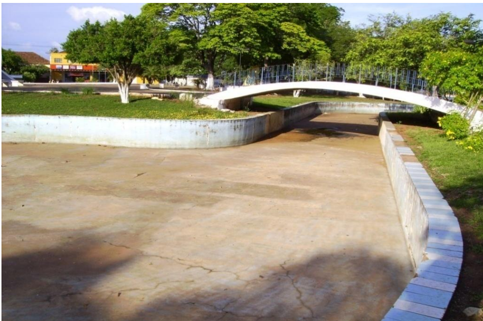
Foto 13: PONTE SOBRE O ESPELHO D'ÁGUA NA PRAÇA DOS ESTUDANTES
