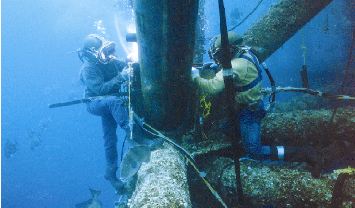
Figura 2.2. Mergulhadores realizando soldagem subaquática. Fonte desconhecida.
