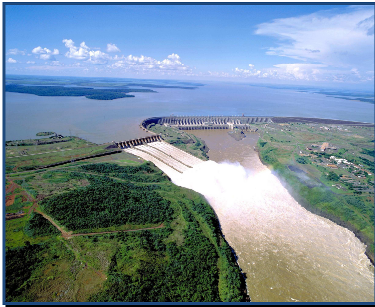
FIGURA 3.3 – Usina hidrelétrica de Itaipu FONTE: Prefeitura Municipal de Foz do Iguaçu (2009)
