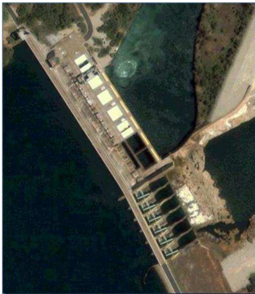
FIGURA 7.6 – UHE de Jaguará – vãos de ampliação – vista aérea FONTE: ANEEL (2009c)
