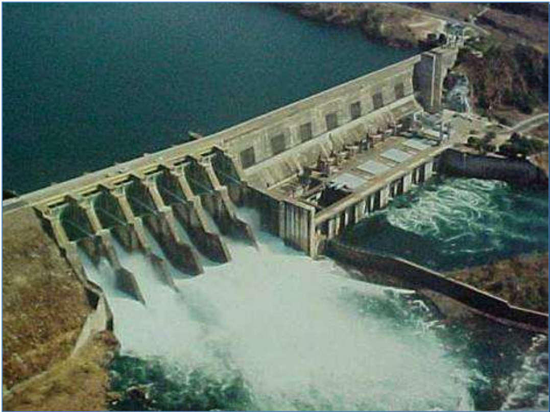
FIGURA 7.4 – Usina hidrelétrica de Jaguará Fonte: CEMIG (2009a)
