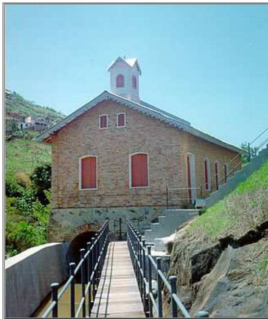
FIGURA 3.1 – Usina hidrelétrica de Marmelos Zero FONTE: Fundação Cultural Alfredo Ferreira Lage (FUNALFA) (2009)
