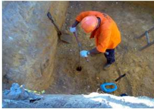
Figura 3.2 Obtenção de amostra amolgada por meio do trado na estrutura T2A cava C
