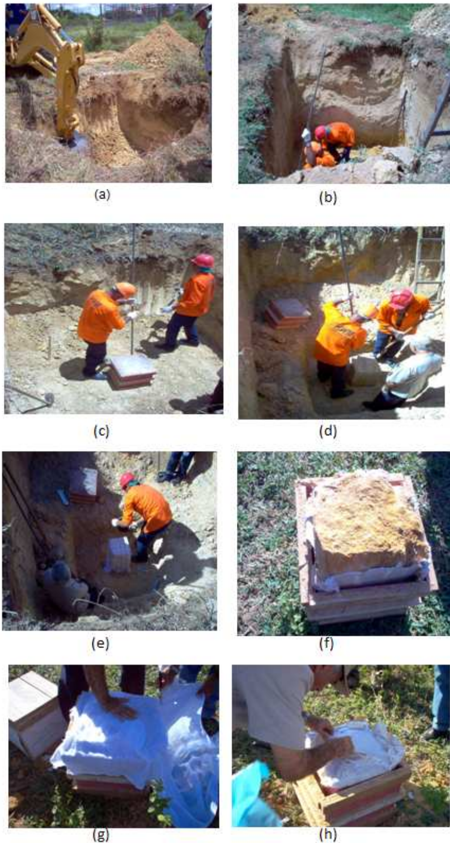
Figura 3.1 Moldagem de blocos - amostra indeformada estrutura T2A cava C - a) Escavação mecânica com a retro escavadeira; b) Escavação manual; c) Marcação do bloco; d) Moldagem do bloco; e) Proteção do bloco com papel alumínio, talagarça e parafina; f) Extração do bloco do fundo da cava; g) Proteção do fundo do bloco; h) Acabamento final.
