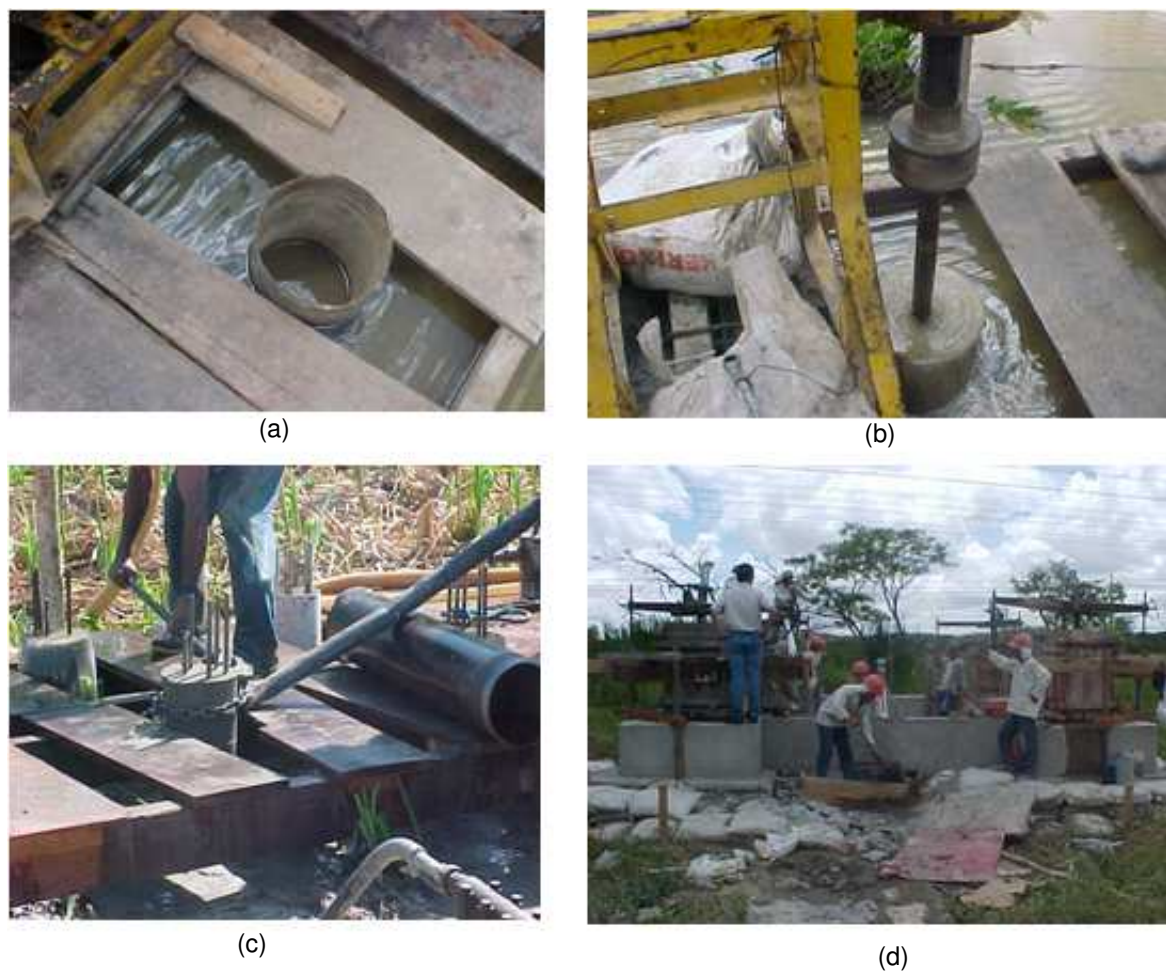
Figura 2.5 Processo de execução de fundação em estaca raiz: a) Instalação do tubo, b) Circulação da água, c) Armação e concretagem da estaca e d) Concretagem do stub no bloco.
