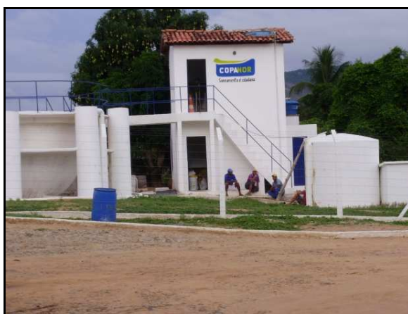
FIGURA 7 - Estação de tratamento de água, São Pedro do Jequitinhonha, Minas Gerais, 2009.
