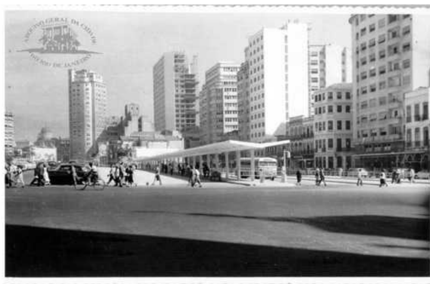
Figura 3.16/ 3.17- Ponto Terminal de ônibus Rua Erasmo Braga (onde hoje está o Ed. Garagem Menezes Cortes). Circa, 1960. Fonte: AGC-Rio.
