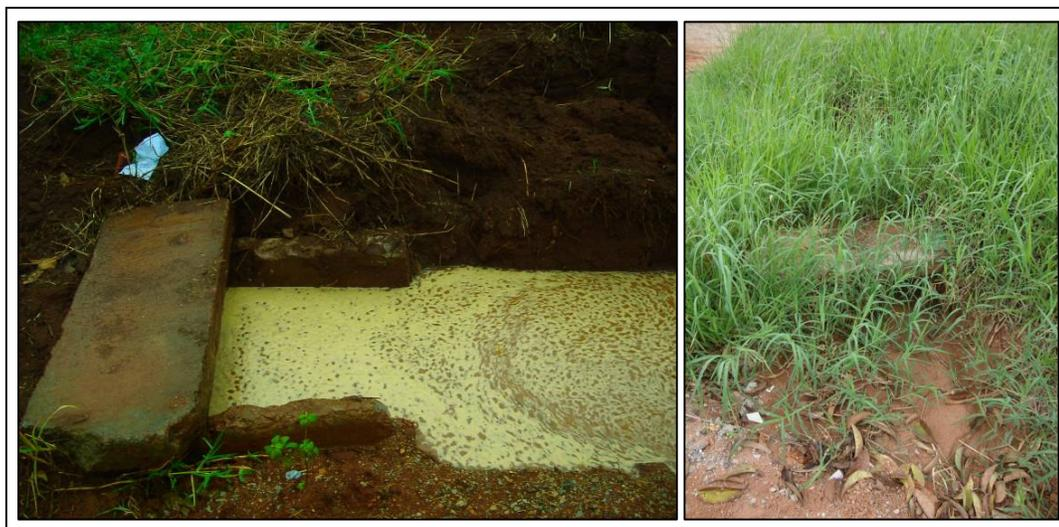
FIGURA 17 – Manilha para captação de água pluvial entupida localizada à esquerda da Rua Rio Amazonas no cruzamento com a Rua Rio Nilo. Foto da esquerda obtida em setembro de 2009 e da direita em janeiro de 2010.
