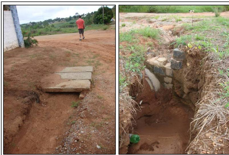
FIGURA 18 – Manilhas situadas na Rua Rio Amazonas, no cruzamento com a Rua Rio Nilo. Fotografia da esquerda, manilha entupida localizada no lado direito. Fotografia da direita ilustra a outra extremidade da manilha, dentro do canal C2, entupida por de sedimentos. (jan. 2010)
