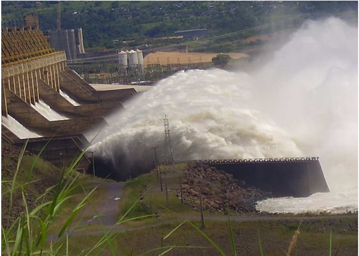
FIGURA 2.1- Foto do vertedouro em operação da Usina Hidrelétrica de Tucuruí no Rio Tocantins, a 350 km ao sul de Belém
