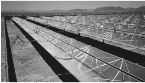
Figura 1.3: Campo composto por fileiras paralelas do coletor IST-PT (ABENGOA, 2009).
