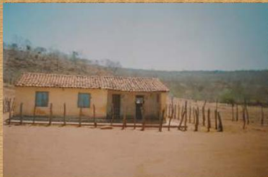
Fachada principal de uma escola rural - Loc. Chapada das Contendas Oeiras-PI/2004
