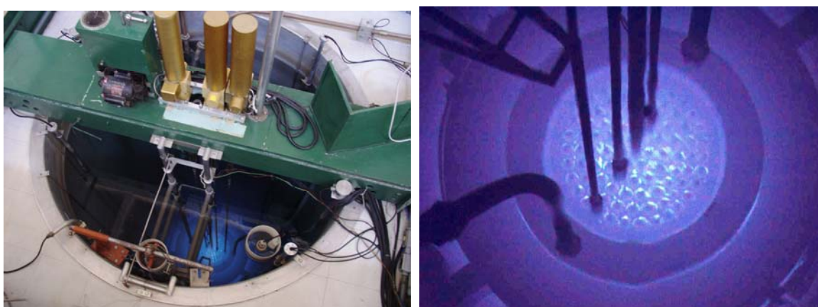
FIGURA 6 – Reator TRIGA IPR-R1 – Detalhes do poço (MESQUITA et al, 2006) e do núcleo com o reator ligado (MESQUITA, 2007)
