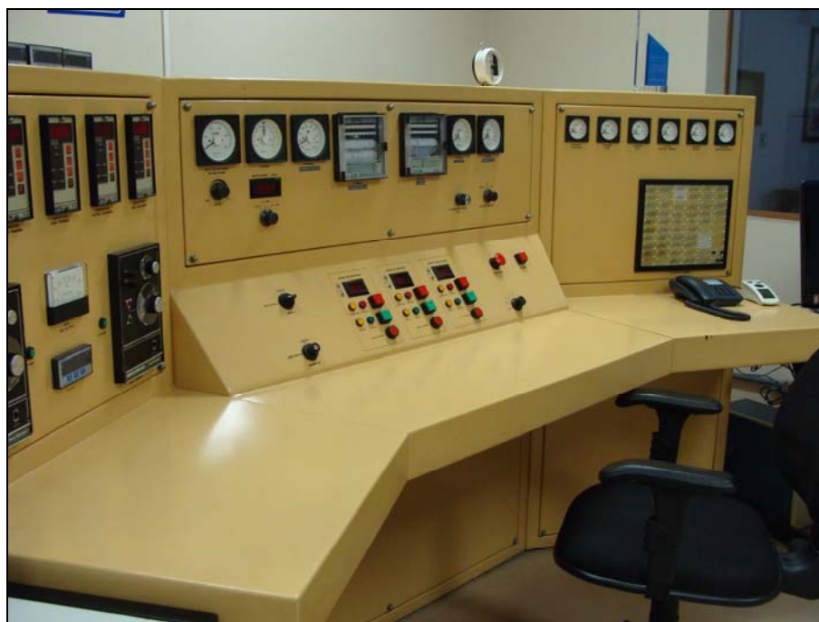
FIGURA 7 – Detalhe da instrumentação da mesa de controle do reator TRIGA IPR-R1
