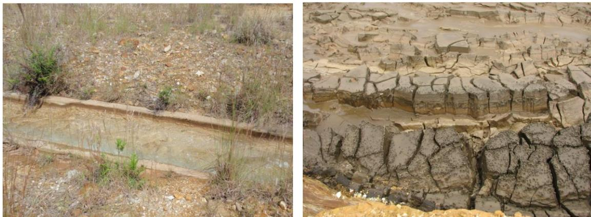
FIGURA 3 - Canaleta com água tratada a esquerda; à direita, precipitado (lama alcalina) gerado no processo de tratamento da drenagem ácida.
