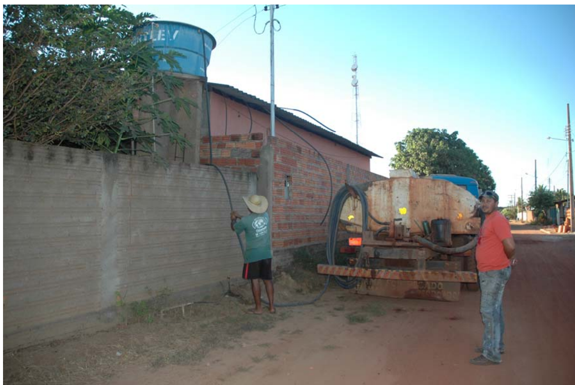
Figura 13 – Forma de Abastecimento de água aos moradores do Município de Ribeirão Cascalheira
